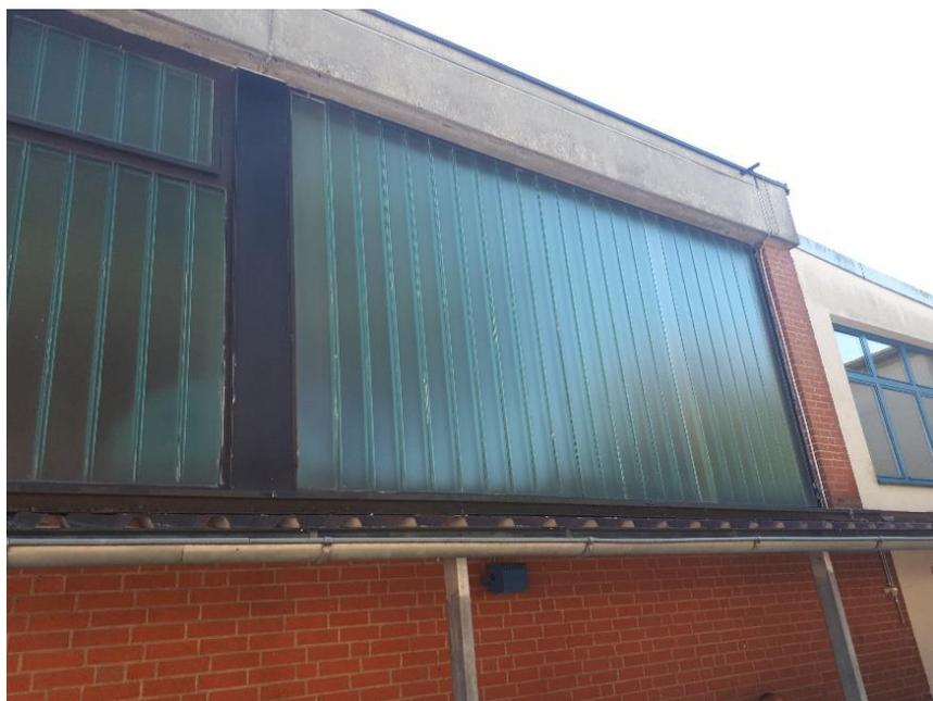
Insbesondere die Profilit-Verglasungen mit dem Betonsturz sorgen für hohe Wärmeverluste. Aber auch das Mauerwerk dieser Baualtersklasse besitzt noch keinen ausreichenden Wärmeschutz.
