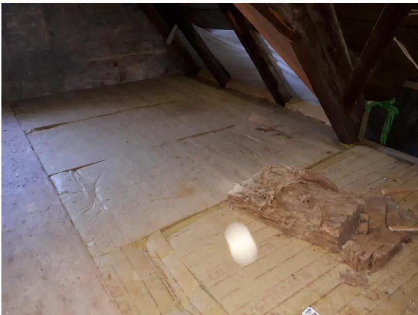
Hier ist der wärmebrückenfreie Übergang von der Zwischensparrendämmung zur obersten Geschosßdecke zu sehen.
