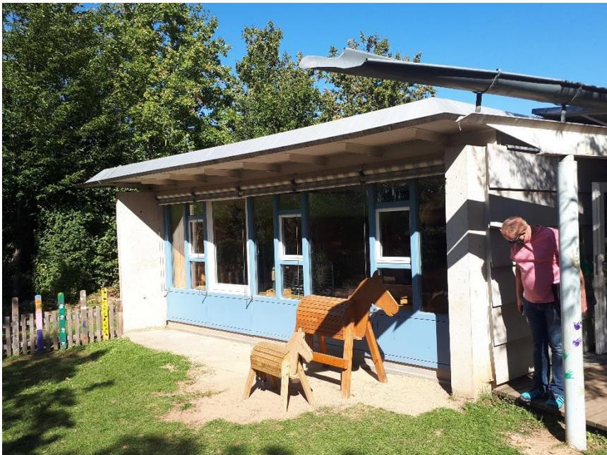
Dieser Gebäudeteil hat seitlich Betonwände mit Dämmung und Fassadenplattenverkleidung. Die Fensterfläche ist auch hier eine Holz-Ständerbauweise mit farbigen Holzelementen.
