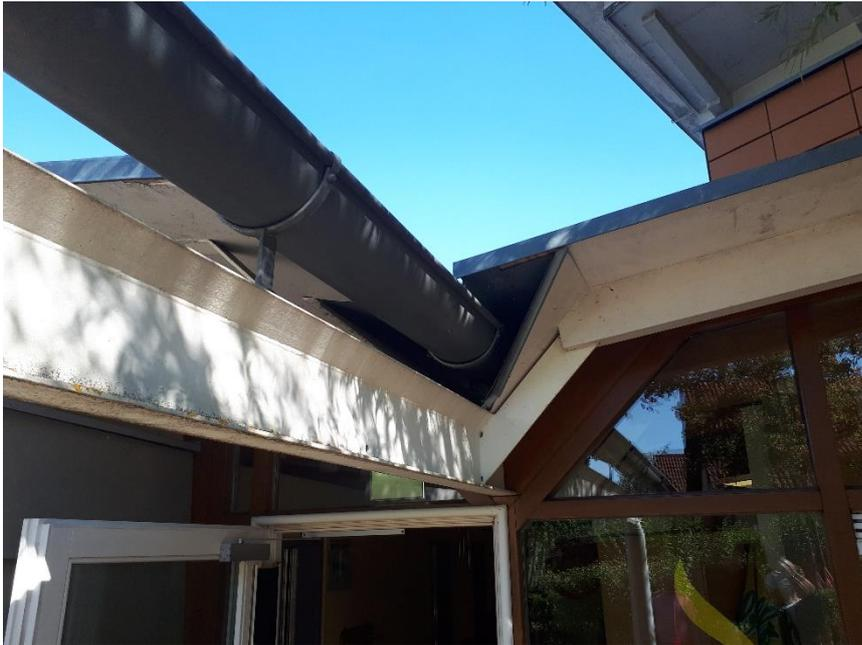
Die Dachentwässerung erfolgt beim Kindergarten innenliegend, quer durchs Gebäude von Ost nach West. Feuchteprobleme konnten nach Lokalisierung der Undichtigkeiten behoben werden.
