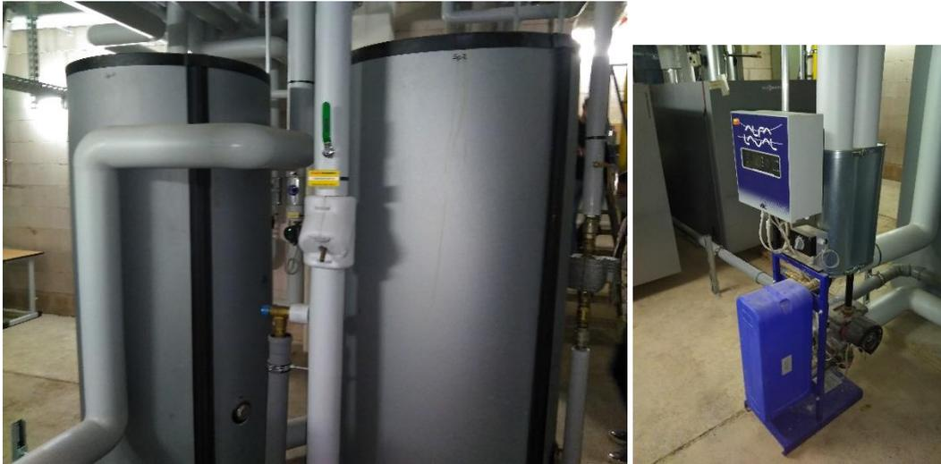
Die Warmwasserbereitung erfolgt zentral über zwei 1.000 Liter Pufferspeicher mit Frischwasserstation.
