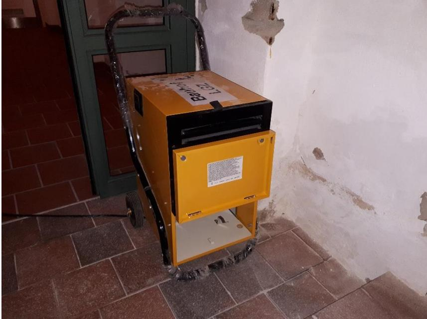
Seit kurzem sind zwei Entfeuchtungsgeräte in Betrieb, die beinahe täglich gelehrt werden müssen. Eine vorhandene Sockelheizung führt derzeit noch zu keiner Verbesserung der Feuchteproblematik.
