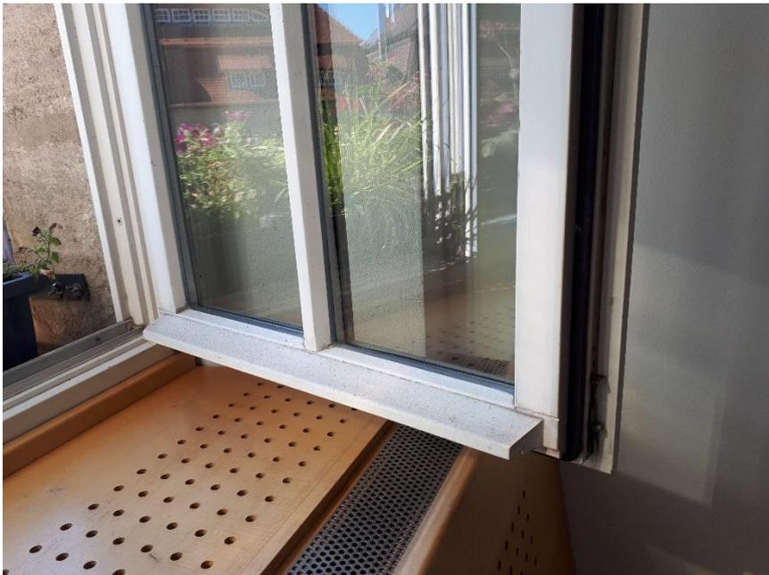
Der Wetterschenkel des Fensterrahmens ist leicht verwittert, ansonsten sind die Fenster in einem guten Zustand. Laut Stempel im Scheibenzwischenraum wurden die Fenster im Jahr 1997 gefertigt und haben somit bereits eine energieeffiziente Edelgasfüllung im Scheibenzwischenraum.
