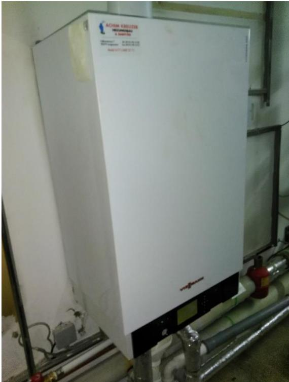
Gasbrennwertgerät Viessmann Vitodens 200-W, Baujahr 2015, Leistung 42kW.
