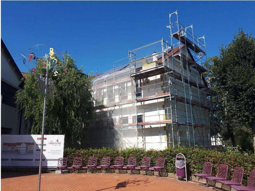
Auf der Seite des Haupteingangs wird derzeit am „Nordflügel“ ein WDVS mit ca. 18 cm dicke aufgebracht.
