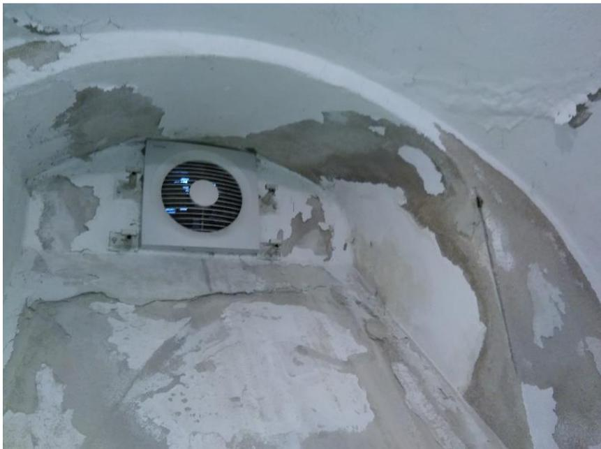
Um den Keller mit Frischluft zu versorgen und die Feuchteluft nach außen zu transportieren, wurden zwei „WC-Lüfter“ installiert.
