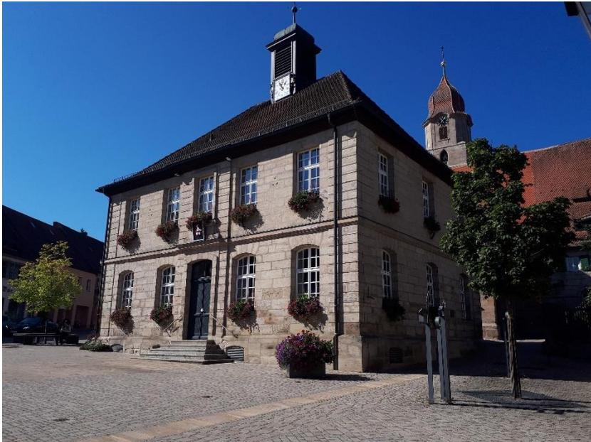
Die Außenwände bestehen aus Sandsteinmauerwerk mit einer Wandstärke von über 90 cm im EG. Gebäudeinnenseitig ist das Sandsteinmauerwerk verputzt. Trotz der Wandstärke hat das Sandsteinmauerwerk einen sehr schlechten U-Wert<sup>5</sup> von ca. 1,3-1,5 W/m<sup>2</sup>K.
