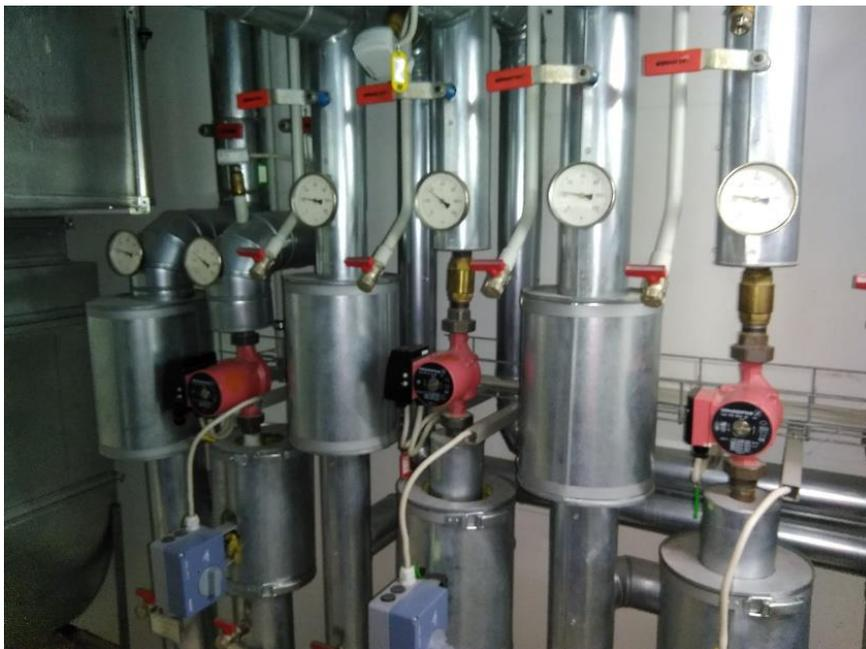
In der Heizungsverteilung sind noch 2 herkömmliche Pumpen installiert. Die restlichen Pumpen sind bereits drehzahlregelt.
