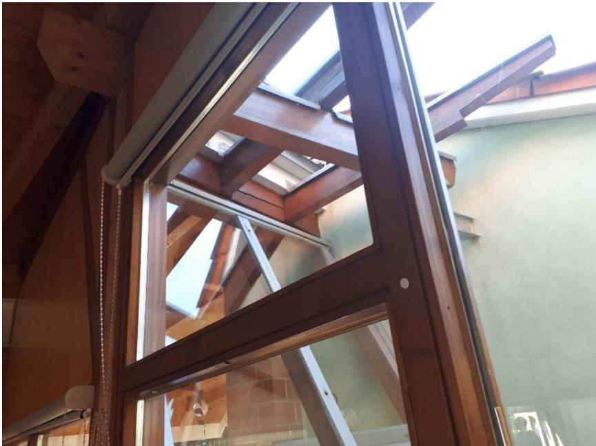
An vielen Stellen sind sehr verschachtelte Details, die eine energetische Sanierung des Gebäudes deutlich erschweren. Die Fenster haben eine 2-Scheiben-Wärmeschutzverglasung, aber noch ohne wärmedämmende Edelgasfüllung im Scheibenzwischenraum. Eine Wärmefunktionsschicht dürfte aber bereits vorhanden sein.
