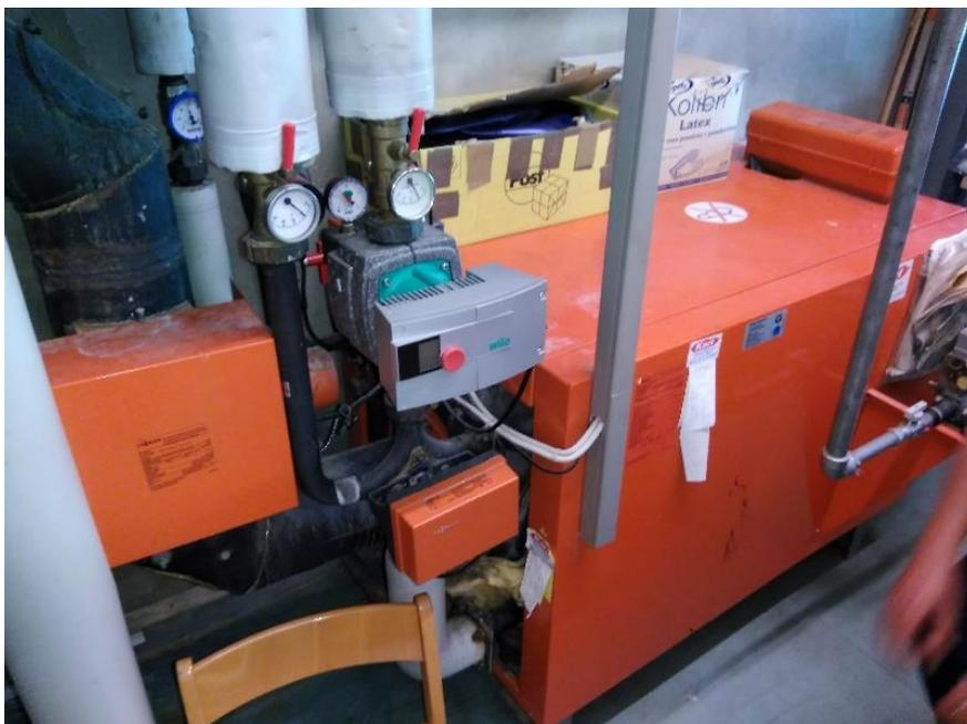
Gaskessel Viessmann, Baujahr 1991, Leistung 65kW. Zum Zeitpunkt Begehung hatte die Heizungsanlage eine Temperatur von 70 °C!
