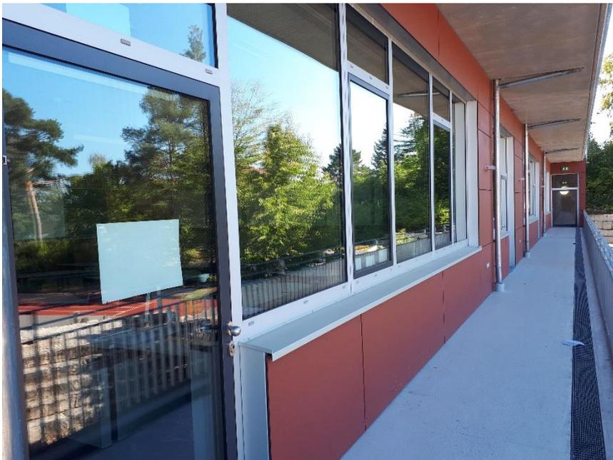
Die Fenster und Fenstertüren besten aus Alurahmen mit 3-Scheiben-Wärmeschutzverglasung.
