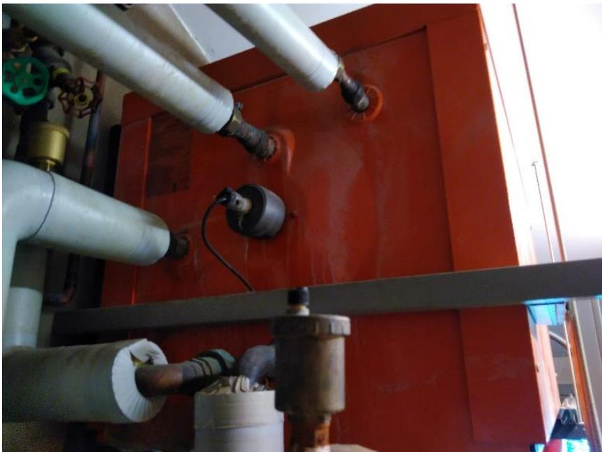
Die Warmwasserbereitung erfolgt über einen liegenden 150 Liter Speicher. Vermutlich hat man sich damals für diese Variante entschieden, da der Heizraum so klein ist.
