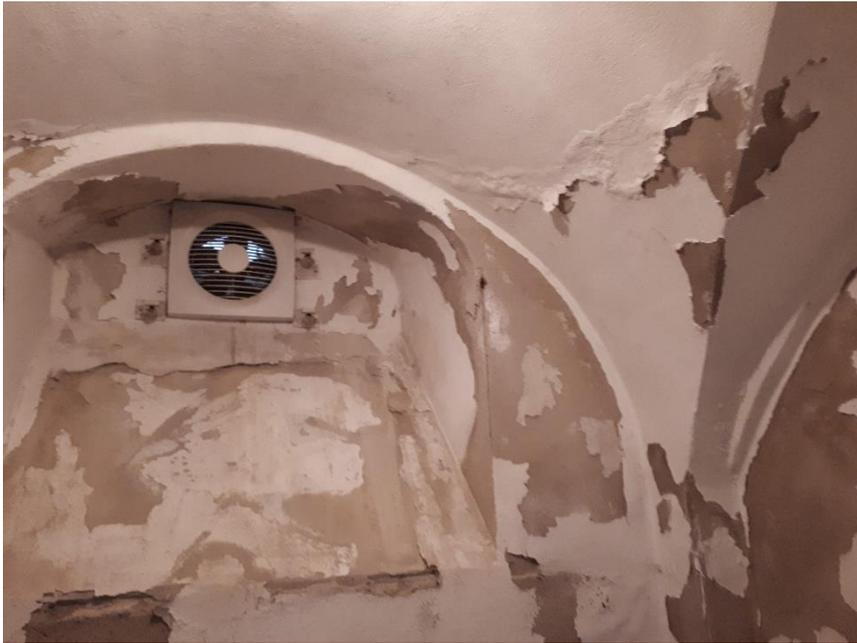
In einigen Nischen sind Außenlüfter eingebaut, die aber insgesamt viel zu klein dimensioniert sind, um die hohe Luftfeuchte abzutransportieren.
