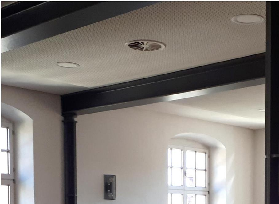
Die Beleuchtung besteht hauptsächlich aus Decken Einbauleuchten und indirekter Wandbeleuchtung. Ab 2015 wurde die Beleuchtung kontinuierlich auf LED-Retrofit umgestellt.
