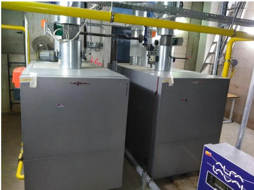
2 x Gasbrennwertgerät Viessmann Vitocrossal 200, Baujahr 2015, Leistung jeweils 115kW.
