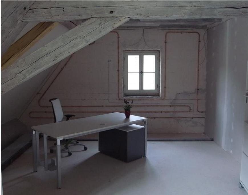
In einigen Außenwandbereichen der Stadtverwaltung wurden im Rahmen der Sanierung 2012 dem Perlitputz Wandheizungselemente installiert. Dadurch entsteht ein angenehmes Raumklima.
