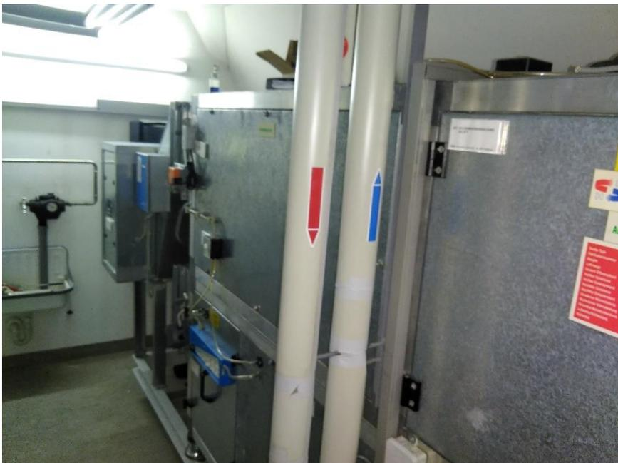
Lüftungsanlage mit Wärmerückgewinnung, Baujahr 1997, Volumenstrom 1.800m<sup>3</sup>/h, 11kW Heizleistung.
