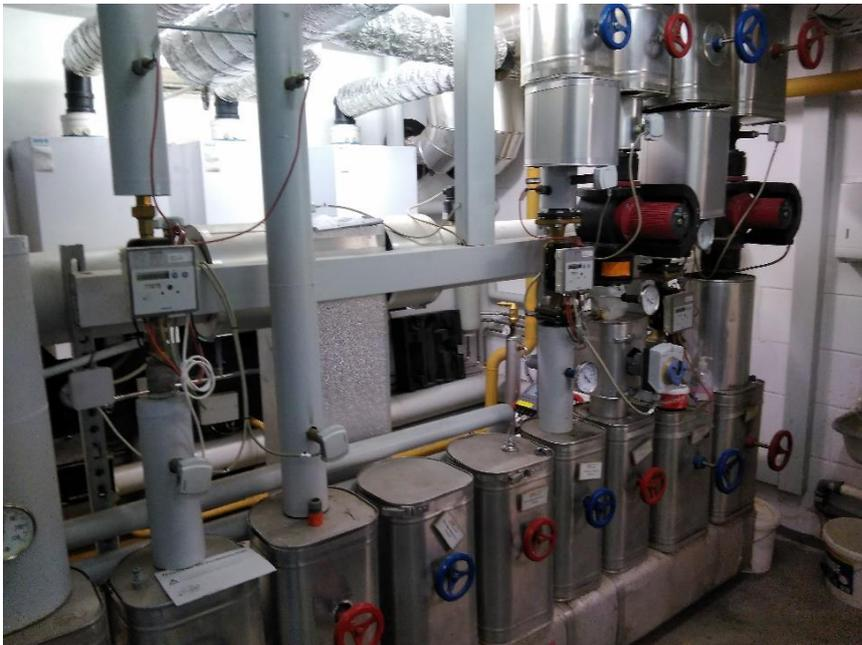
In der Hauptverteilung sind drehzahlregelte Pumpen der ersten Generation installiert.
