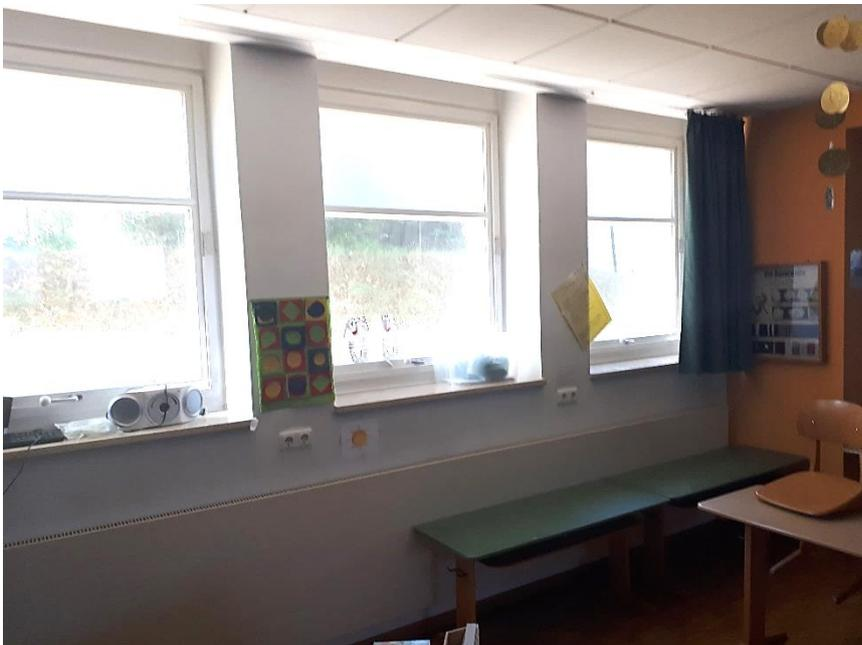
Die noch vorhandenen Holz-Verbundfenster werden alle durch Alufenster mit 3-Scheiben-Wärmeschutzverglasung ersetzt.
