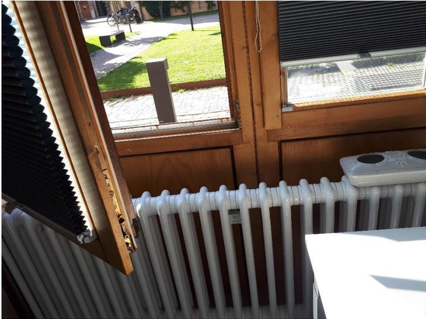
Wegen des Denkmalschutzes darf kein außenliegender Sonnenschutz als sommerlicher Wärmeschutz angebracht werden. Die Heizkörper vor den Holzelementen sorgen im Winter für hohe Wärmeverluste.
