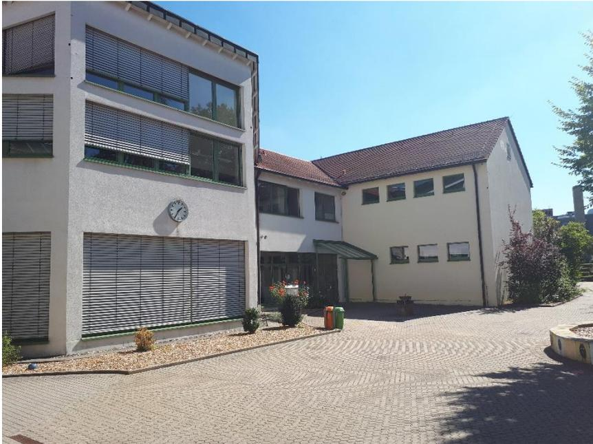
Bereits sanierter Bereich mit WDVS und Alu-Fenster mit 2-Scheiben-Wärmeschutzverglasung.
