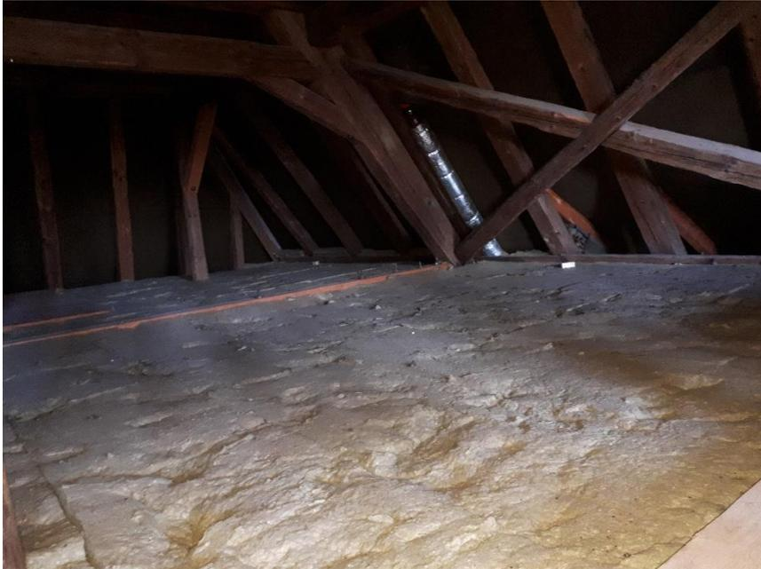
Der Spitzbogen über dem Dachgeschoss ist auch beim Gebäudeteil Stadtwerke mit 20 cm Mineralwolle gedämmt.
