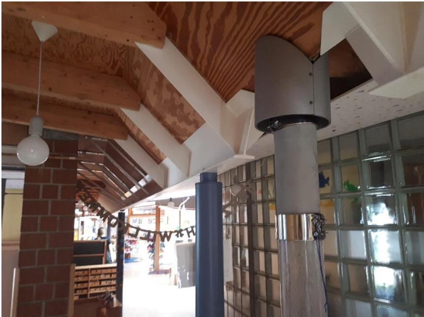
Die innenliegende Dachentwässerung erfolgt über transparente Entwässerungsrohre (hier im Vordergrund). Das Dachtragwerk ist teils Holz, teils Stahlkonstruktion.
