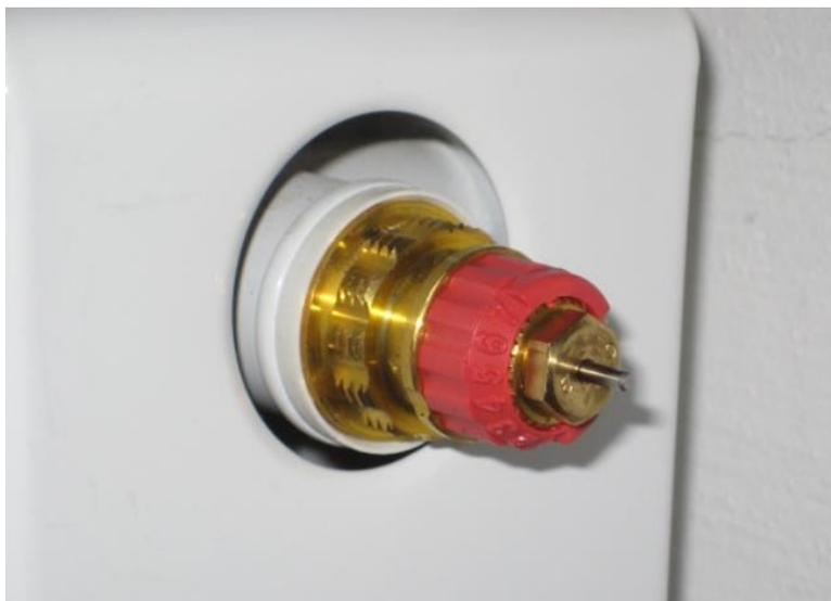
Zur Durchführung des hydraulischen Abgleichs müssen voreinstellbare Thermostatventile an den Heizkörpern nachgerüstet werden.
