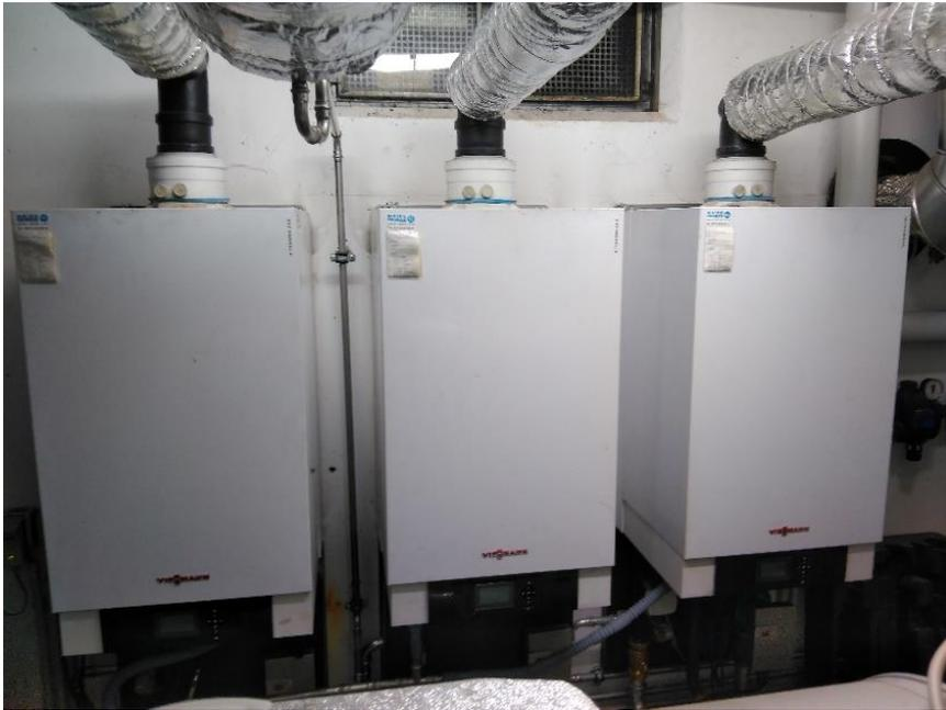
Für die Gebäude Betreutes Wohnen, Stadtwerke und Rathaus wurde eine zentrale Heizungsanlage errichtet. Drei Gasbrennwertgeräte Vitodens 200-W, Baujahr 2012, Leistung jeweils 100kW erzeugen die Wärme.
