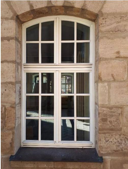
Die Holzfenster wurde nach Anforderungen des Denkmalschutzes erstellt und mit einer 2-Scheiben Wärmeschutzverglasung gefertigt.
