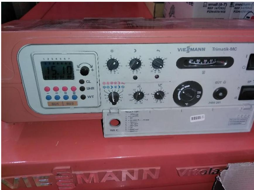
Die Heizungsregelung entspricht noch immer den gesetzlichen Anforderungen, aber nicht der einer effizienten Heizungsregelung. Es ist außerdem fraglich, ob die Regelung noch richtig funktioniert.
