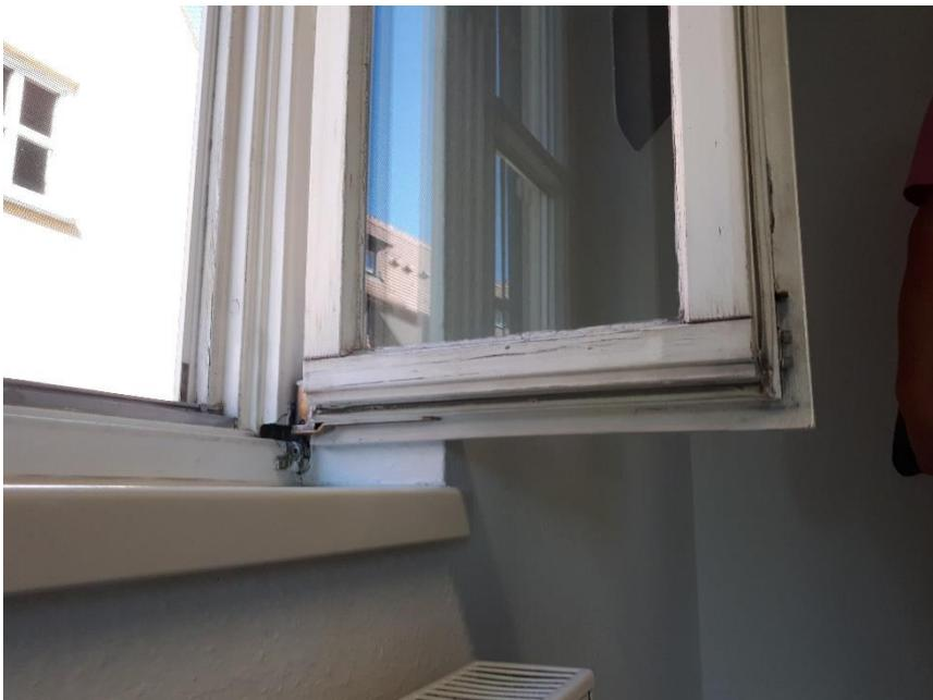
Die Fenster wurden kurz nach der 2. WSVO von 1984 erstellt. Eine 2-Scheiben-Verglasung dieser Bau-
