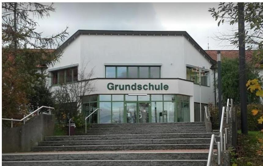
Bereich Haupteingang, bereits saniert u.a. mit Alu-Fenstern und 2-Scheiben-Wärmeschutzverglasung.
