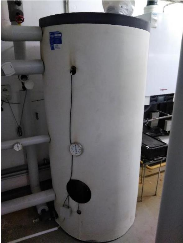
Die Warmwasserbereitung erfolgt zentral über einen 500 Liter Warmwasserspeicher. Nur im Dachgeschoß des Rathauses wird das Warmwasser dezentral über Elektro- Speicher erzeugt.
