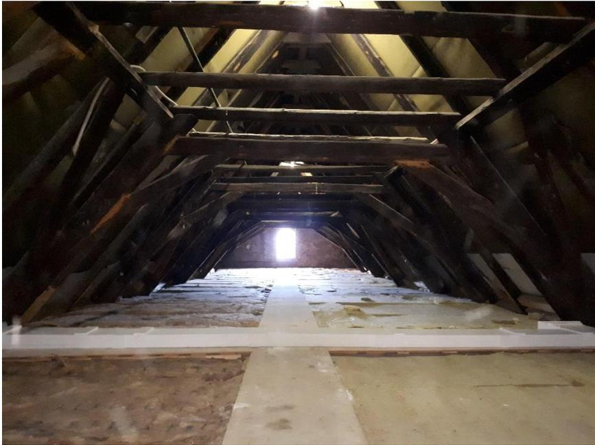
Die oberste Geschossdecke zum nicht ausgebauten Spitzboden ist mit 20 cm Mineralwolle gedämmt.
