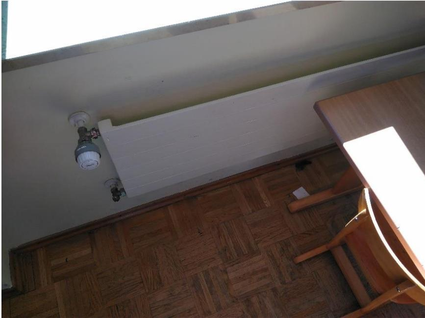
Die Wärmeabgabe erfolgt mittels Heizkörper. Laut Aussage des Hausmeisters werden bei der Heizungssanierung alle Heizkörperventile erneuert.
