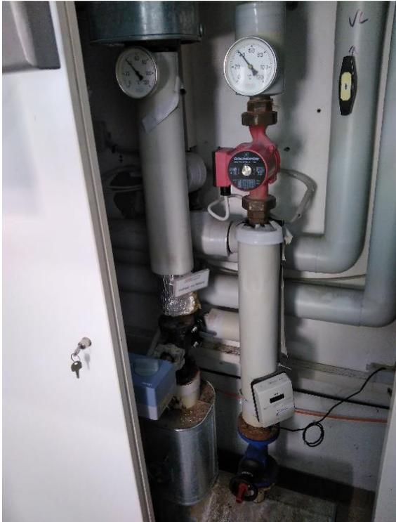
In der Heizungsverteilung ist noch keine Hocheffizienzpumpe installiert. Die Heizungsrohre sind von außen stark korrodiert.
