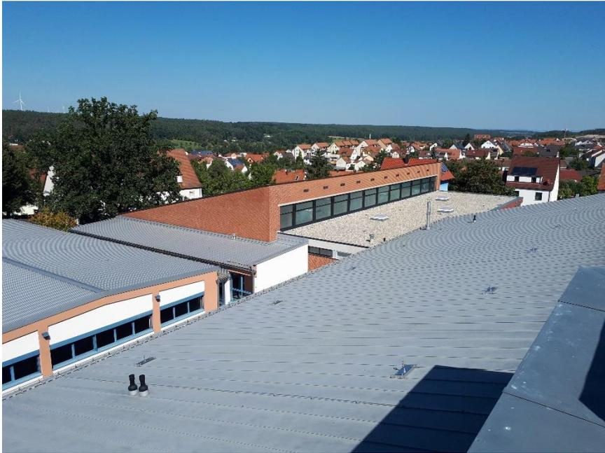
Auch die Dächer der Mittelschule wurden entsprechend den aktuellen Anforderungen gedämmt und mit einer neuen Blecheindeckung versehen. Oben im Bild ist die Alte Turnhalle, links im Bild ist die neue Turnhalle zu sehen.
