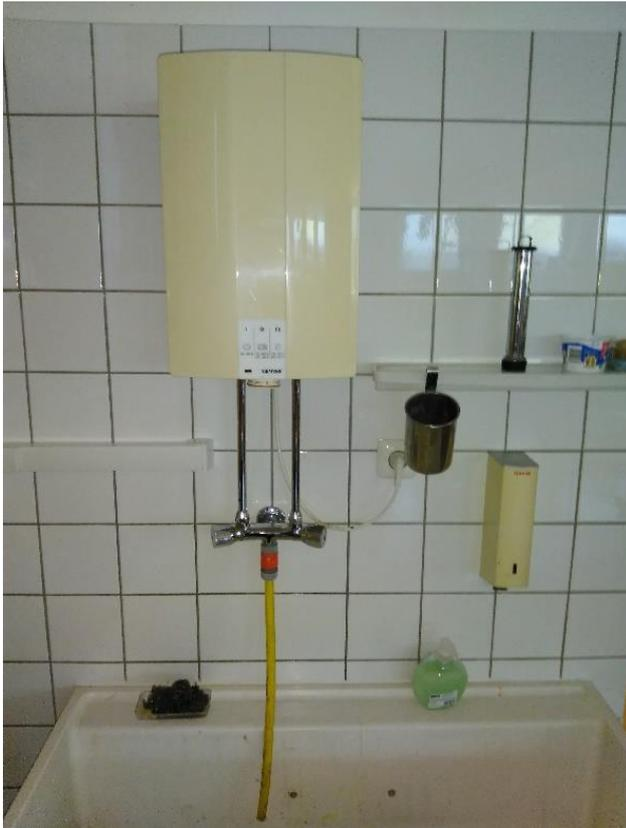
Die Warmwasserbereitung erfolgt dezentral über Elektrospeicher.
