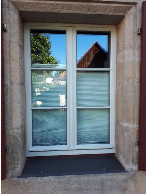
Die Holzfenster wurden nach Anforderungen des Denkmalschutzes erstellt und mit einer 2-Scheiben Wärmeschutzverglasung gefertigt.
