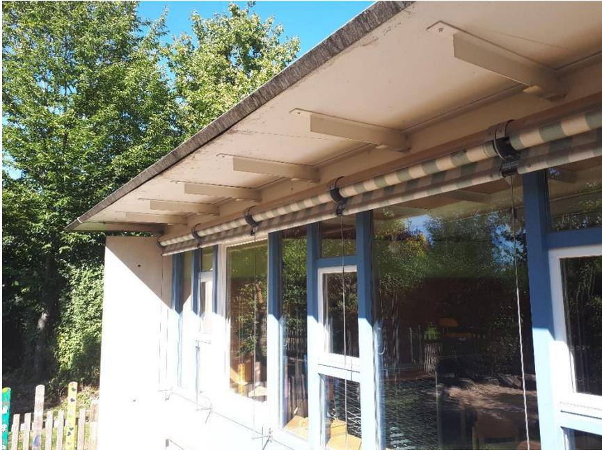
Die teilweise vorhandenen Stahldurchdringungen sorgen auch für erhöhte Wärmeverluste.
