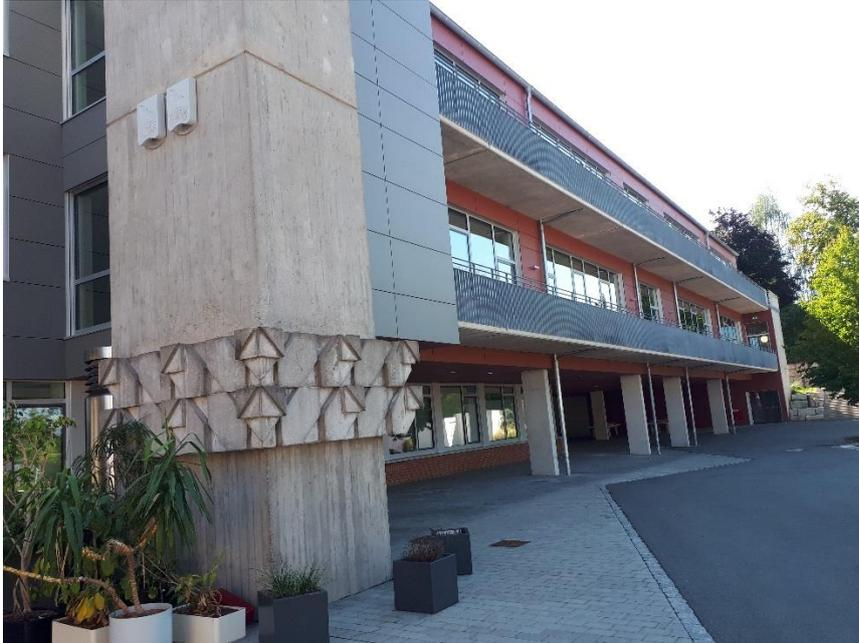
Die neu gebauten Bereiche (hier Klassentrakt) bestehen aus einer Betonkonstruktion mit außenseitiger Dämmung und einer Verkleidung aus Fassadenplatten. Im Vordergrund ist der Bestands-Schornstein zu sehen.
