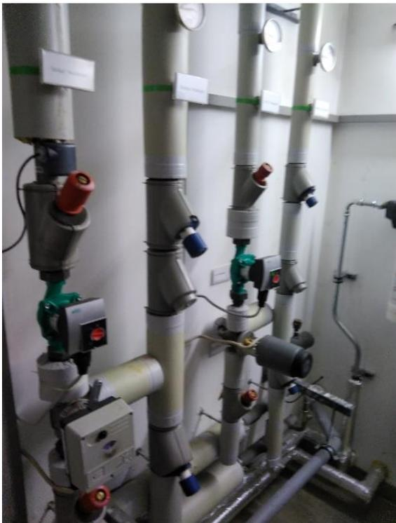
In den Heizkreisen sind drehzahlgeregelte Pumpen vorhanden, die ebenso 2015 installiert wurden.
