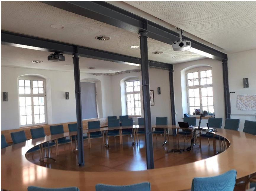
Auch im Sitzungssaal befindet sich eine Stahlkonstruktion zur Lastabtragung.
