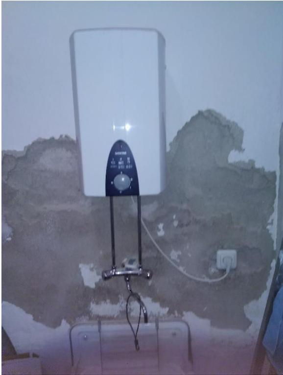
Die Warmwasserbereitung erfolgt dezentral über Elektrospeicher.
