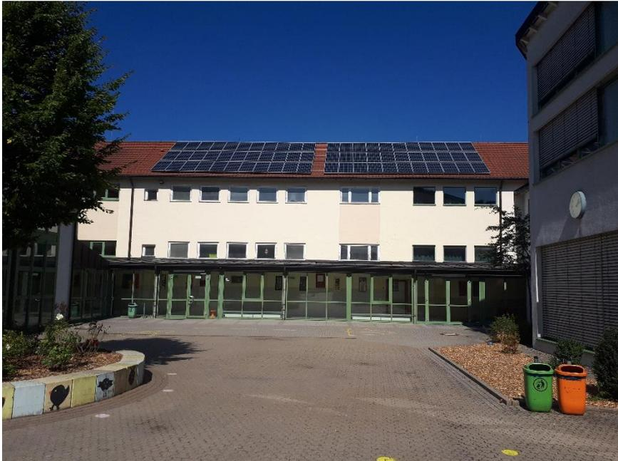
Der hier vorhandene Laubengang wird im Rahmen der Teilsanierung abgerissen und zweigeschossig neu erstellt. In den Obergeschossen sind auch noch die Holzfenster aus den 60er Jahren vorhanden.
