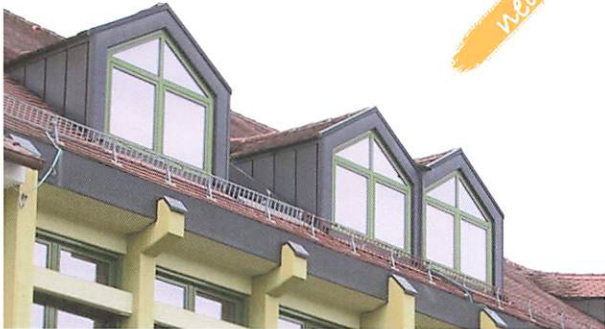
Kastengauben und Blechgauben unterschiedlicher Ausformungen entsprechen nicht dem historischen Ortsbild.
