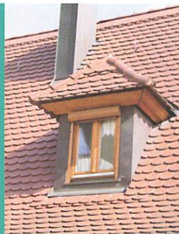
Kastengauben und Blechgauben unterschiedlicher Ausformungen entsprechen nicht dem historischen Ortsbild.
