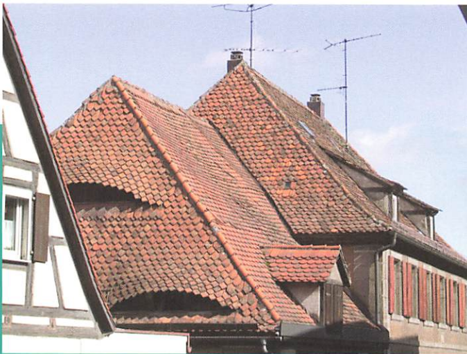
Historische Dachelemente Anwesen Untere Ringstraße 2
