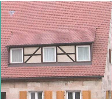
Kastengauben und Blechgauben unterschiedlicher Ausformungen entsprechen nicht dem historischen Ortsbild.
