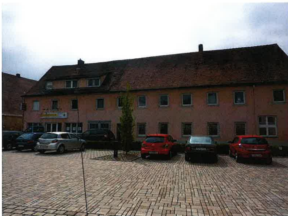
Bild 2: Ansicht Gebäude, Flur-Nr. 230/7, Alte Zennstraße 20, mit Wohnung im DG und Parkplatz vorne
