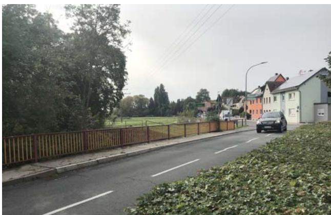
Die Straßenbrücke über die Zenn ist ein Engpass bei Hochwasser
