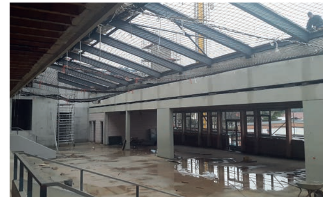
Stahlbauarbeiten am neuen Dach über der Aula
