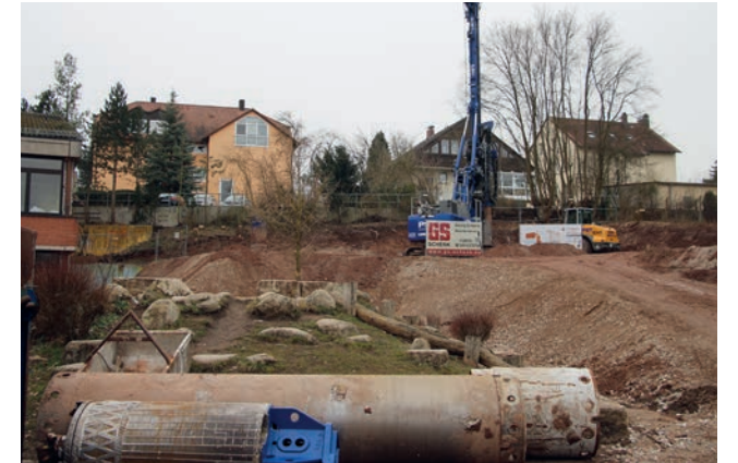
Spatenstich, Beginn der Spezialtiefbauarbeiten (Bohrpfahlwände)
