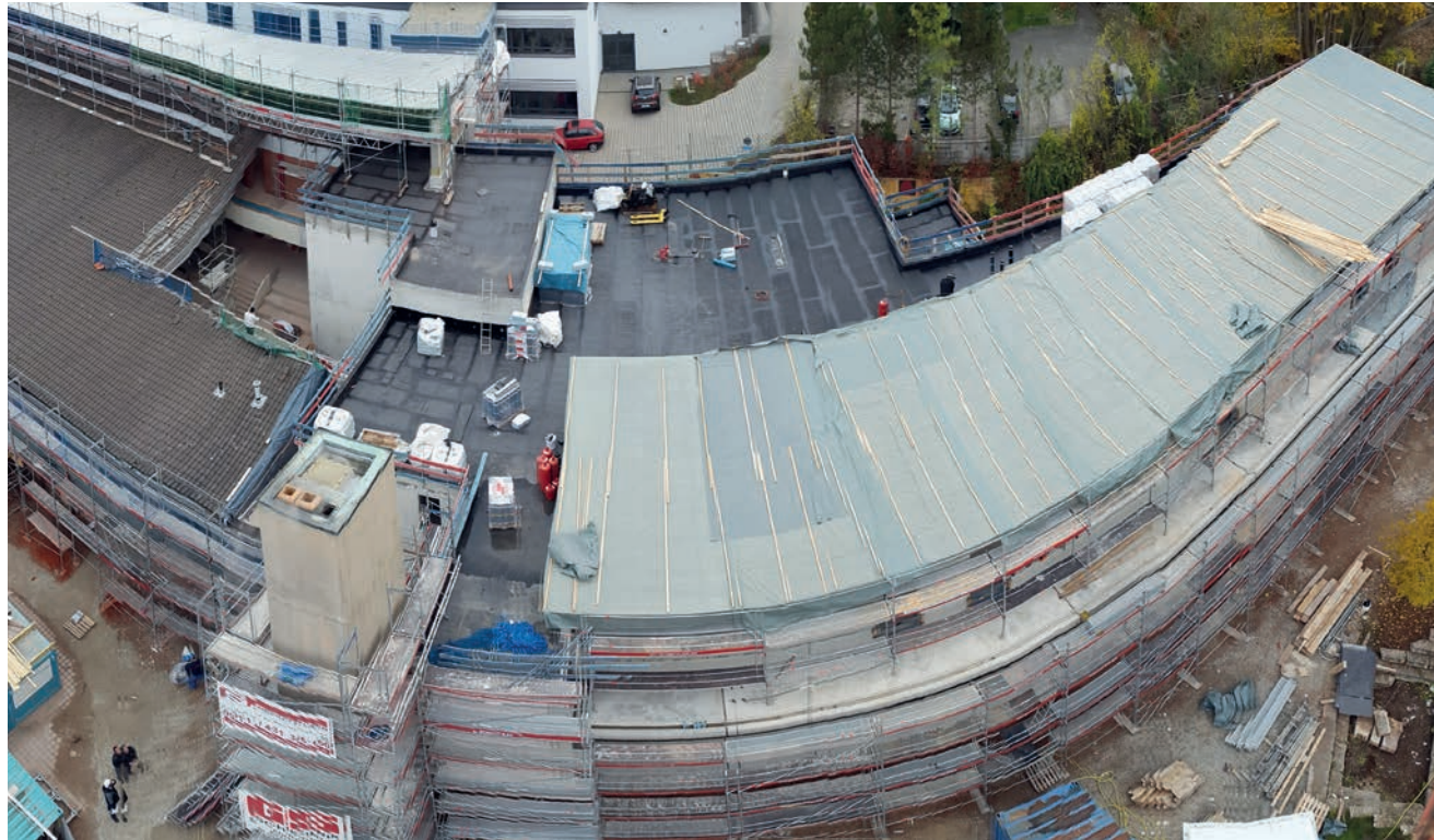
Schulkomplex aus der Kranperspektive – Altbau Aula vor Abbruch des Daches (links)/Fertigstellung Rohbau Neubau (rechts)
