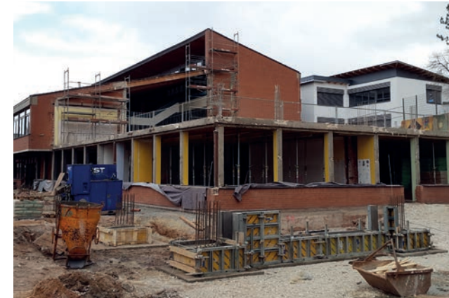
Fertigstellung der Abbrucharbeiten/Beginn der Fundamentierung des Neubaus
